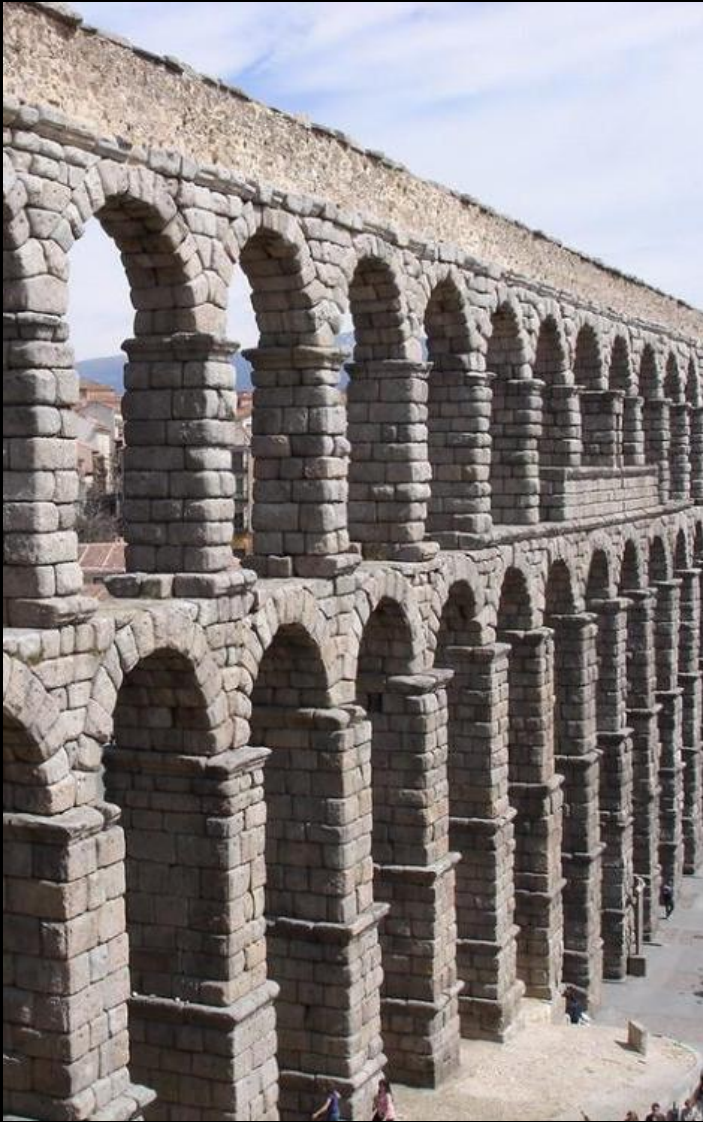
Segovia acquedotto romano
